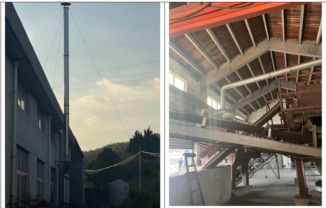
布袋除尘（破碎粉尘）
