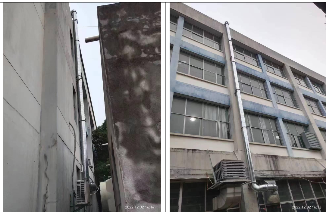
注塑废气排气筒
