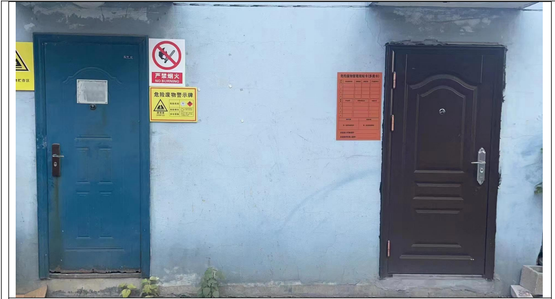
危险废物暂存场所
