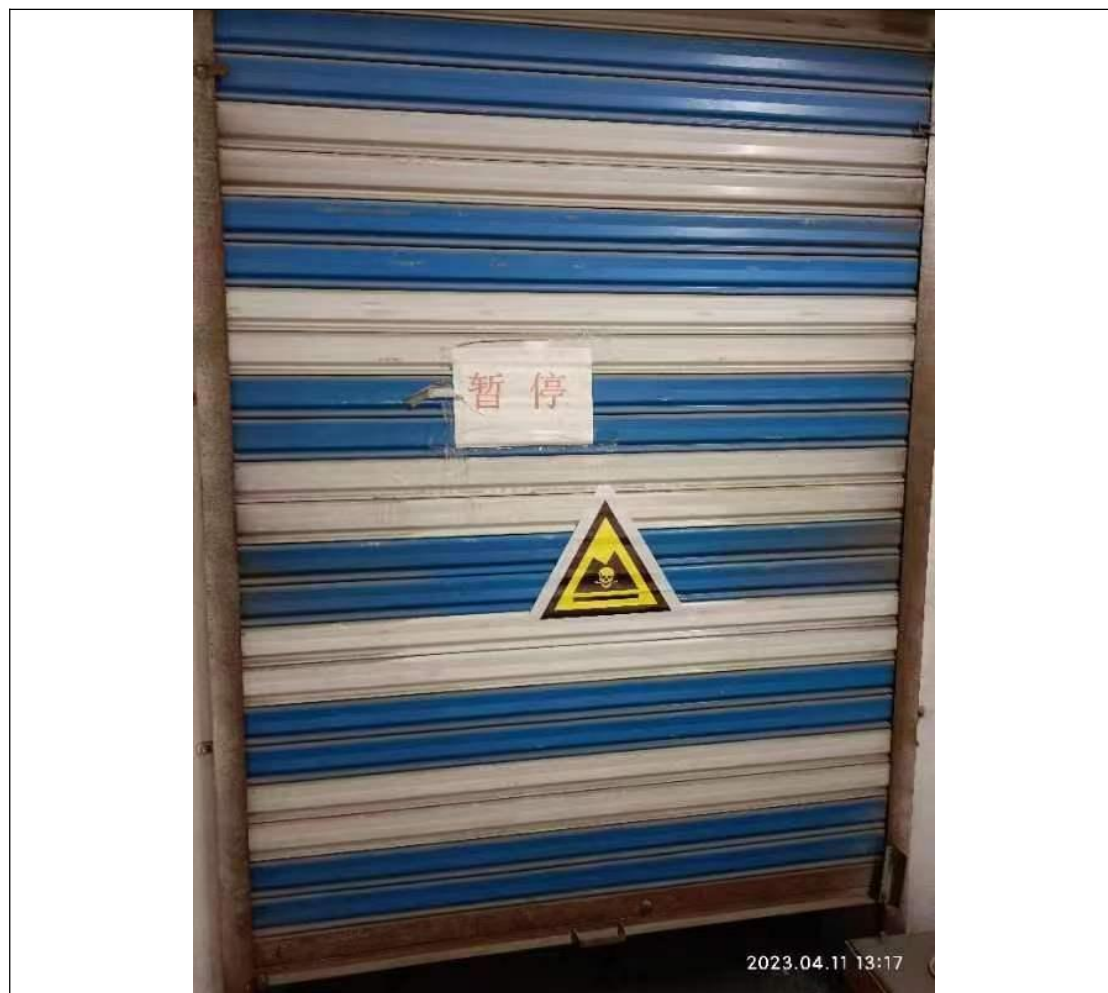
危险废物暂存场所
