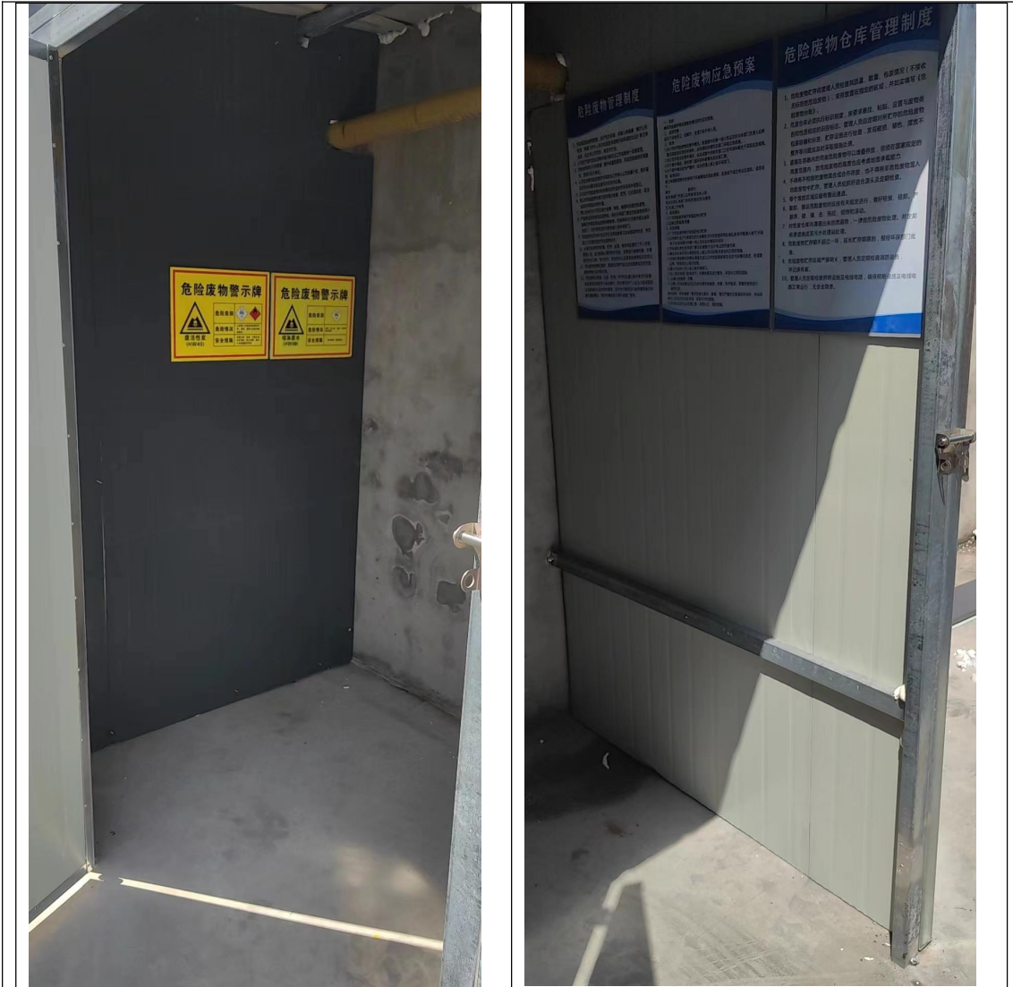
危险废物暂存场所
