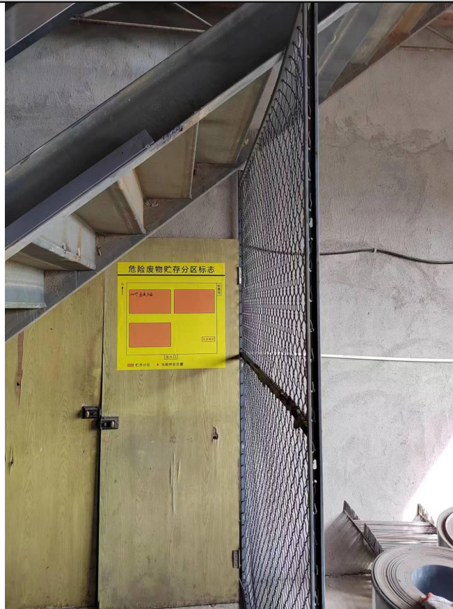
危险废物暂存场所
