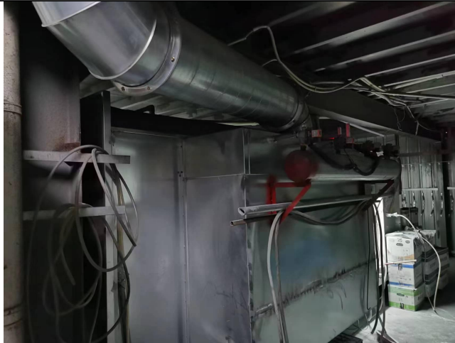
喷台自带滤芯除尘及排气管道
