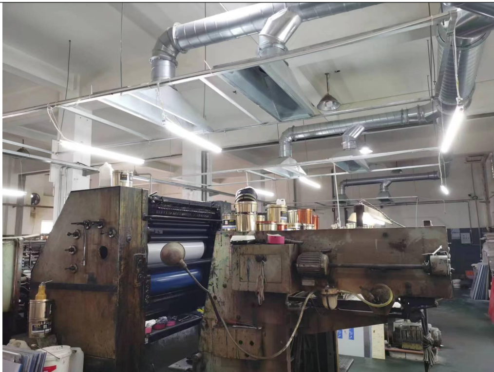
印刷和清洗废气集气罩收集
