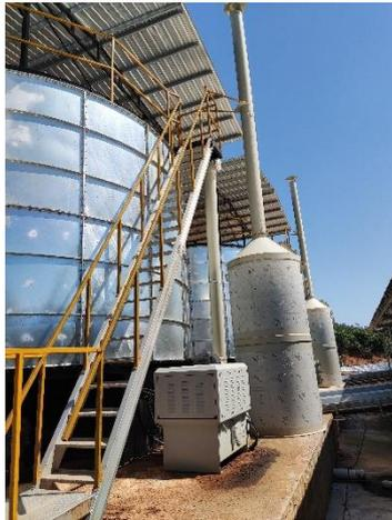
发酵废气喷淋塔
