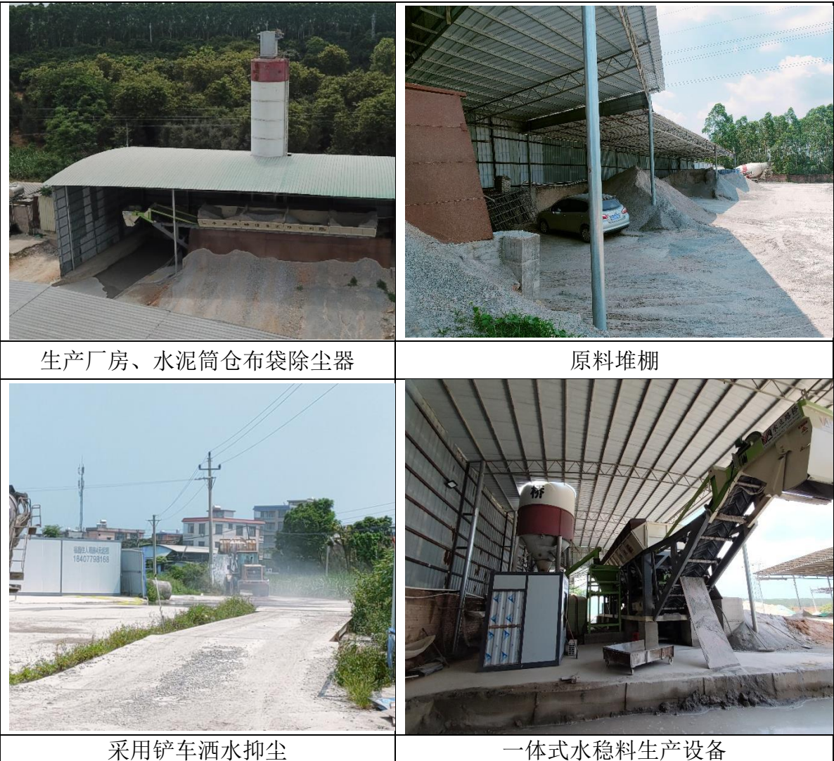
图5-1 废气治理设施
