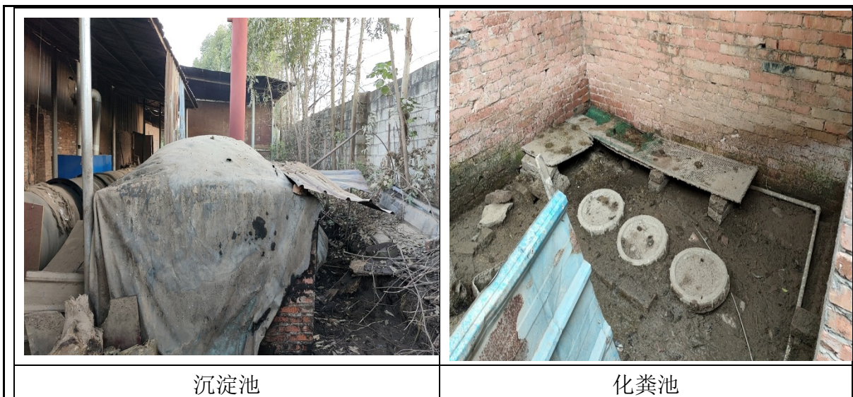
图5-5 项目废水治理设施
