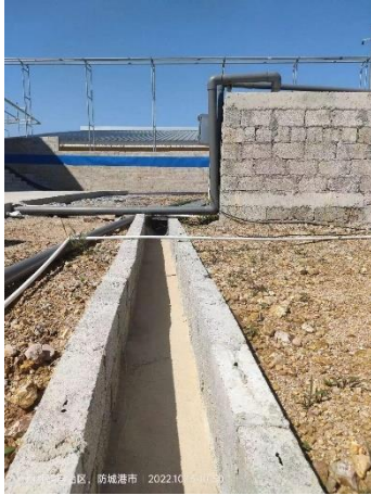
污水处理站边雨水沟
