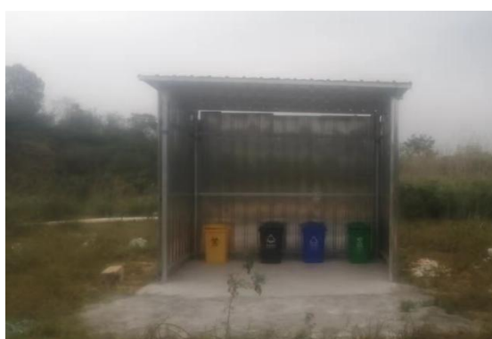
一般固体废物暂存间
