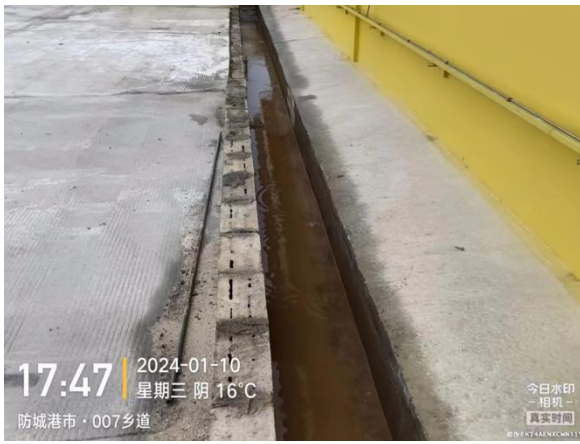
猪舍边雨水沟（区）
