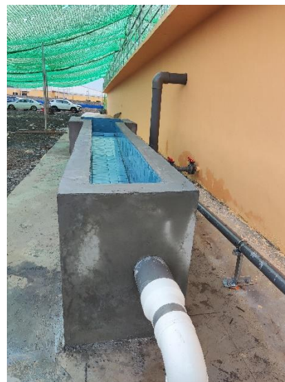
污水处理站尾水出水口
