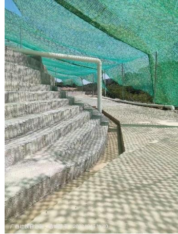
污水处理站边雨水沟
