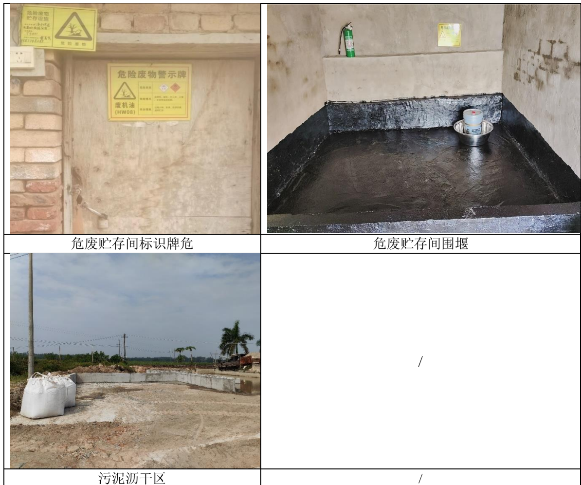
图5-3 项目固废治理设施
