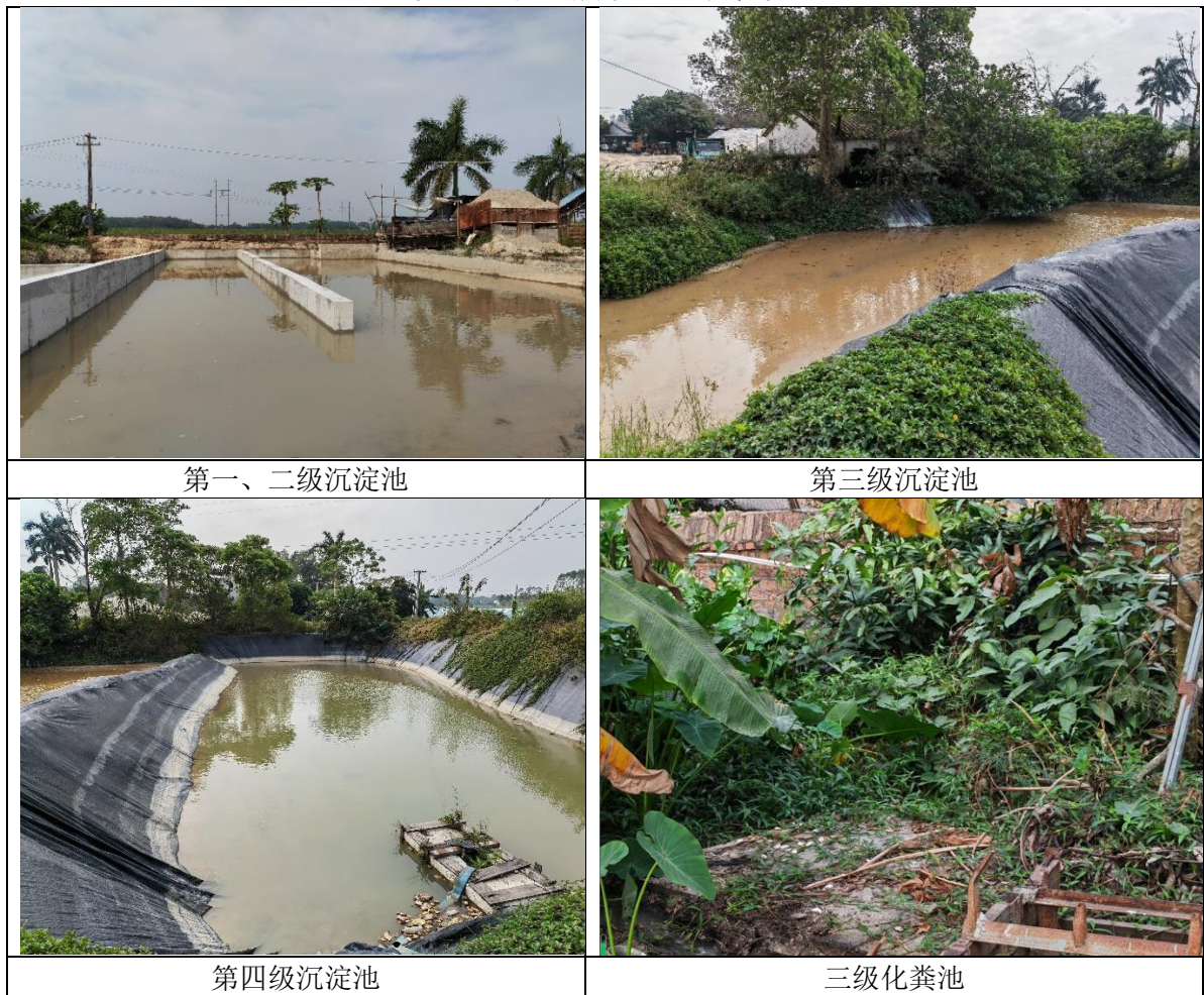
图5-3 项目废水治理设施
