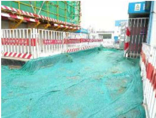
防尘网临时覆盖 (2021年6月)
