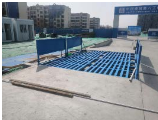
洗车沉淀池（2020年6月）
