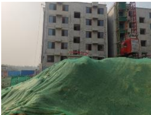
防尘网临时覆盖（2022年9月）
