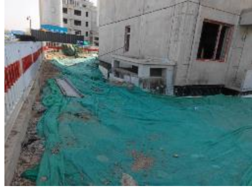
防尘网临时覆盖（2022年3月）
