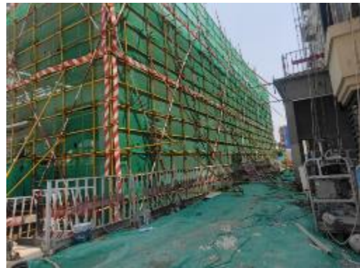
防尘网临时覆盖（2022年6月）
