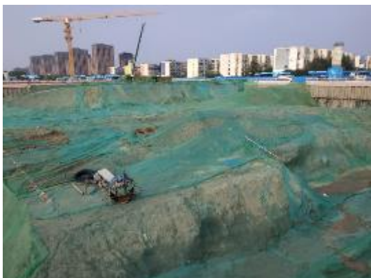
防尘网临时覆盖（2020年9月）
