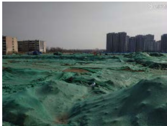
防尘网临时覆盖（2020年3月）
