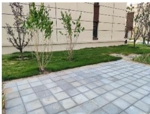
透水砖铺装 (2023年6月)
