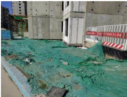
防尘网临时覆盖 (2021年9月)
