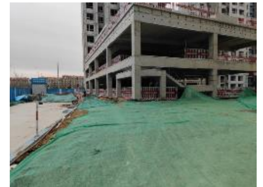
防尘网临时覆盖 (2021年12月)
