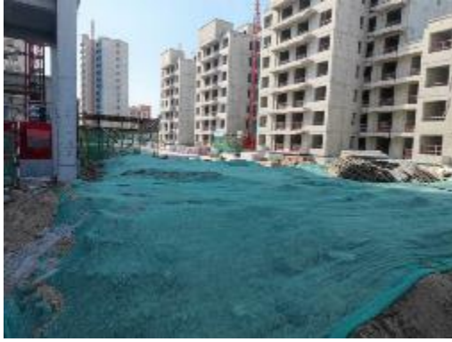
防尘网临时覆盖（2022年3月）
