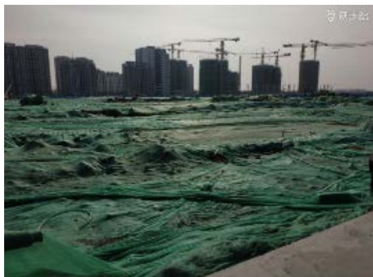
防尘网临时覆盖（2020年3月）
