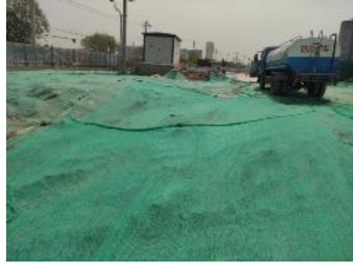
防尘网临时覆盖 (2023年3月)
