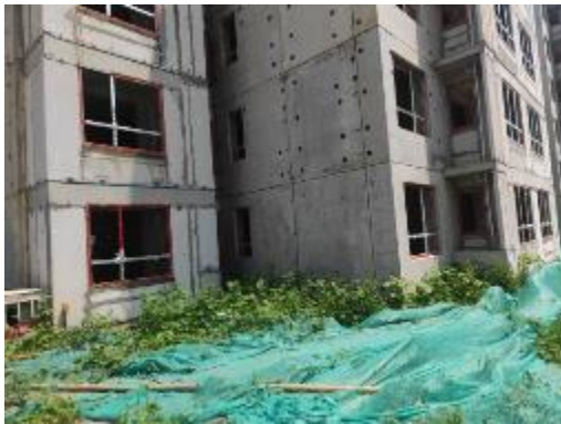
防尘网临时覆盖（2022年6月）
