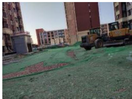
防尘网临时覆盖（2022年12月）
