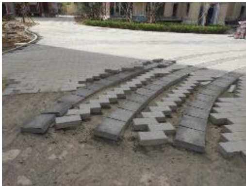
透水砖铺装 (2023年3月)
