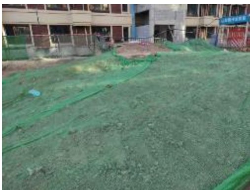
防尘网临时覆盖（2022年12月）
