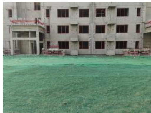
防尘网临时覆盖（2022年9月）
