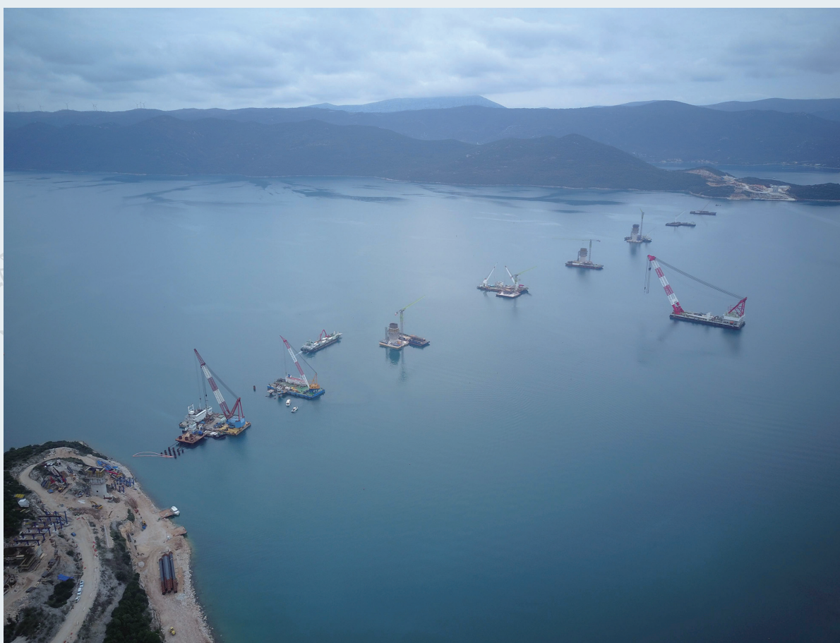
施工中的克罗地亚佩列沙茨跨海大桥 图片来源：新华社
