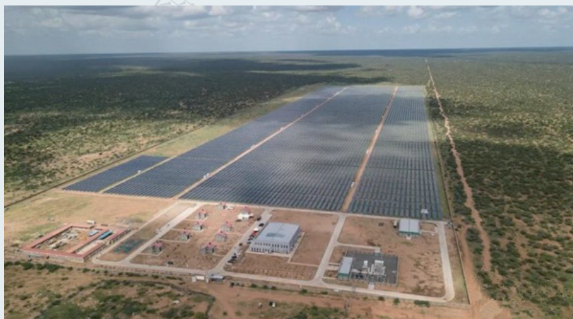
肯尼亚加里萨 50 兆瓦光伏发电项目 图片来源：中国能源建设集团有限公司
