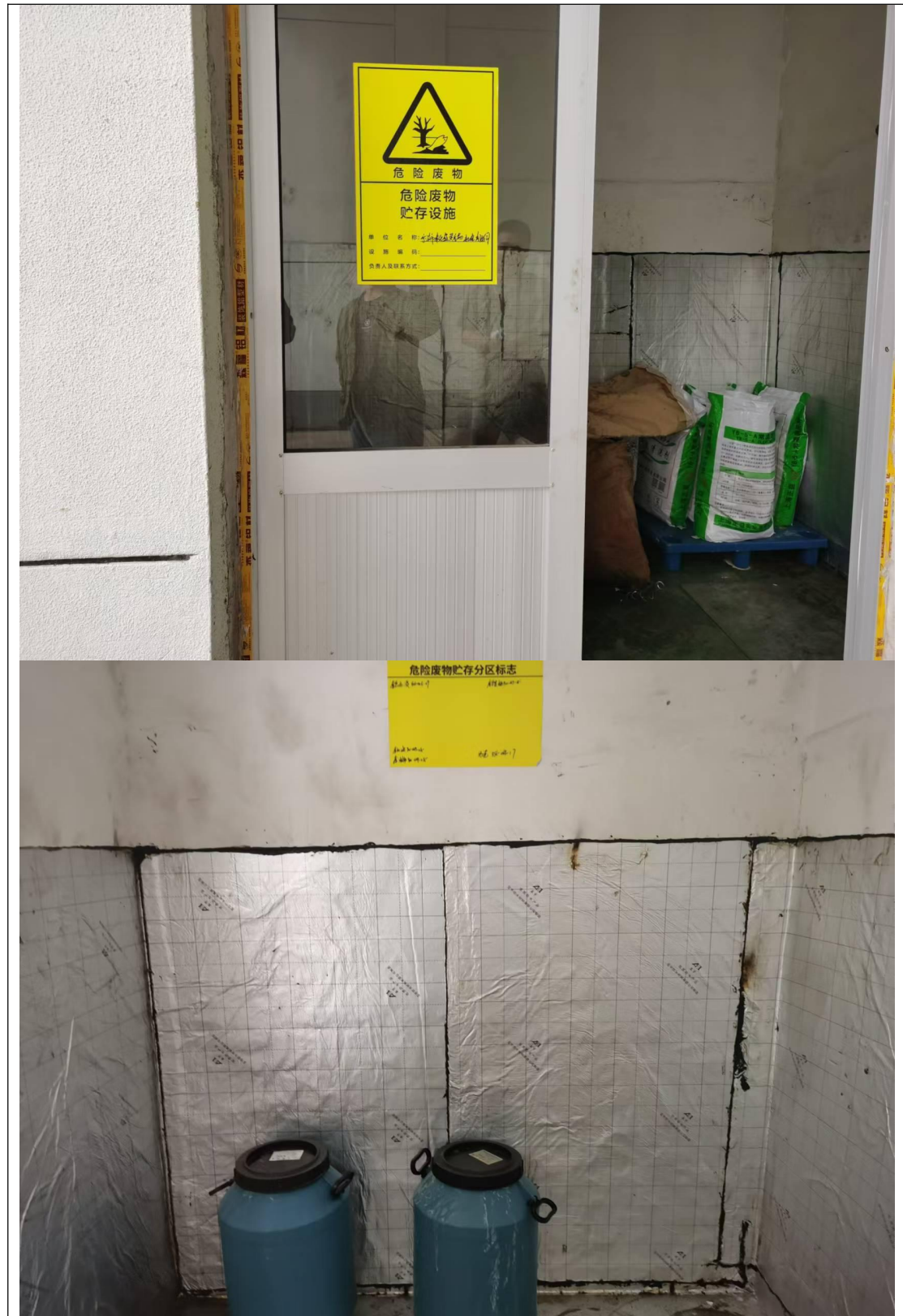
危险废物暂存场所
