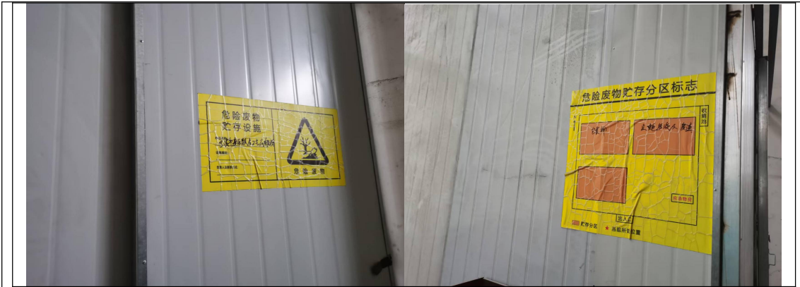
危险废物暂存场所
