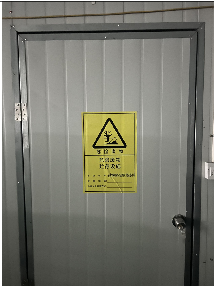
危险废物暂存场所
