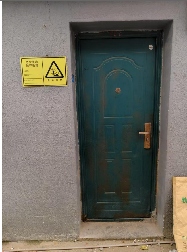
危险废物暂存场所
