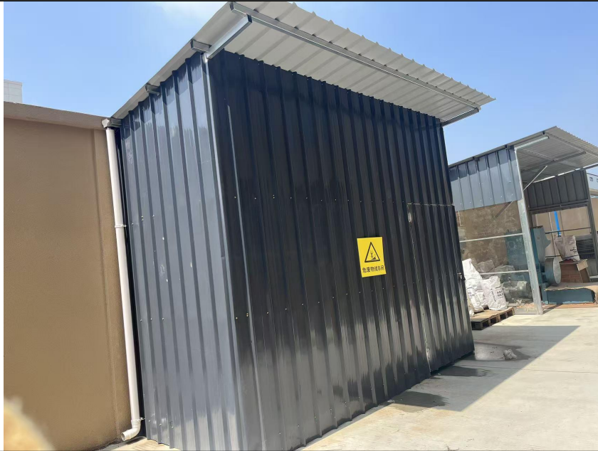
危险废物暂存场所
