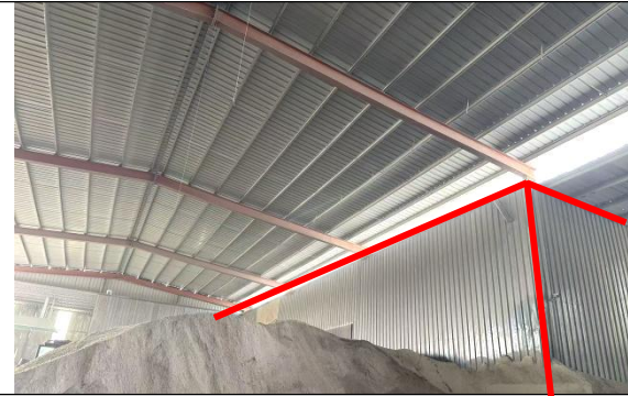
独立的建筑垃圾机械破碎线封闭车间
