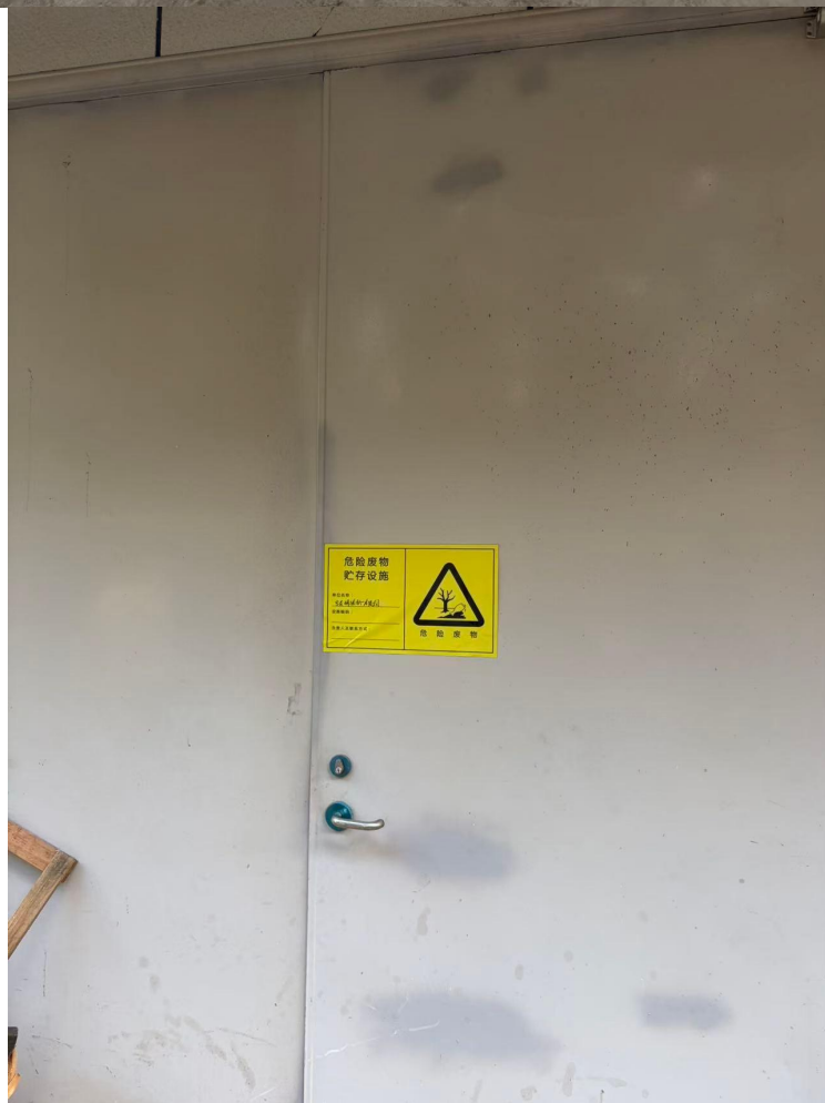
危险废物暂存场所
