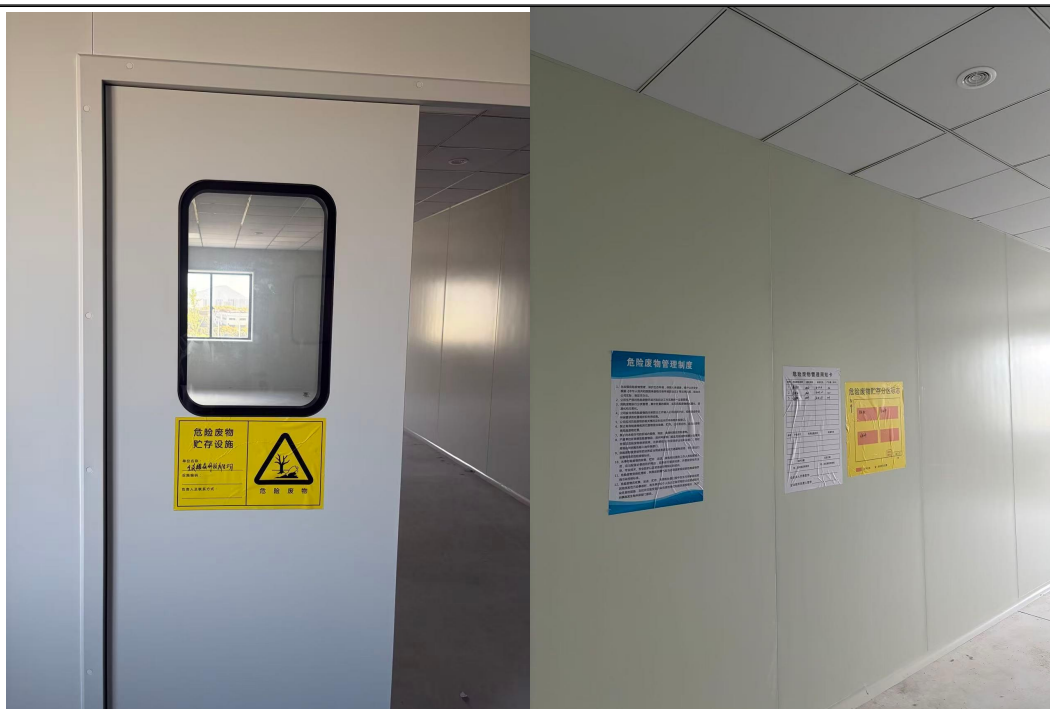
危险废物暂存场所
