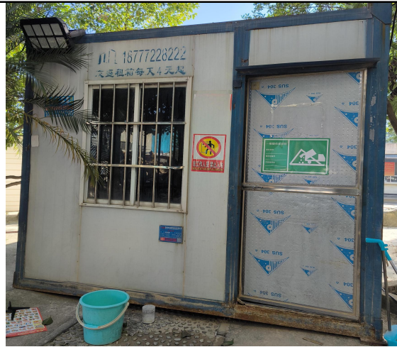
一般固废暂存间
