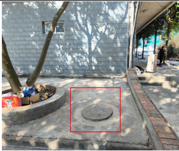
图5-2 废水治理设施
