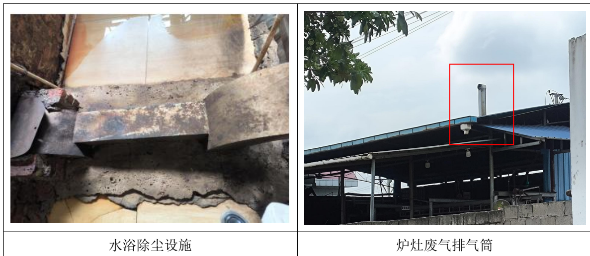
图 5-1 废气污染防治设施
