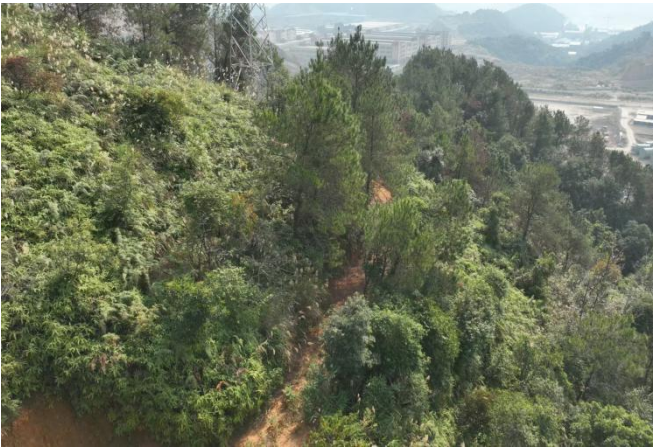
5号施工道路复绿
