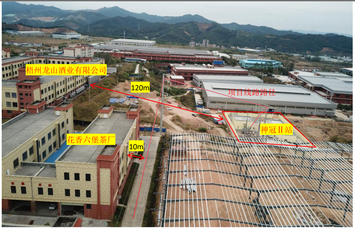
图 4-4 扶典站~神冠II站 110kV 输电线路沿线照片
