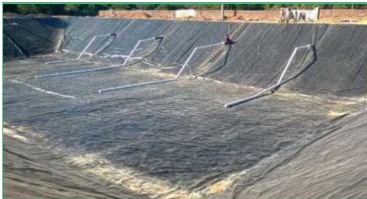
图 5.2-4 黑膜沼气池内部示意图
