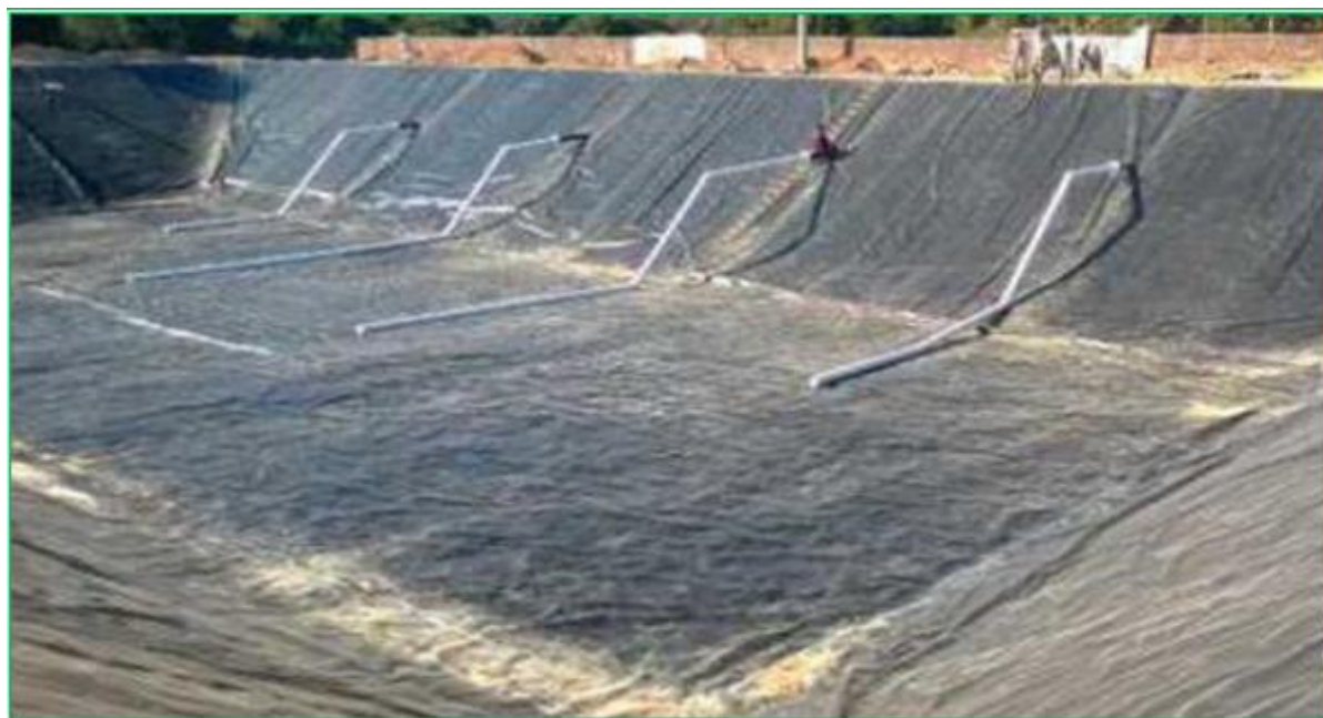
图 5.2-4 黑膜沼气池内部示意图
