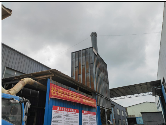
布袋除尘器+DA003
