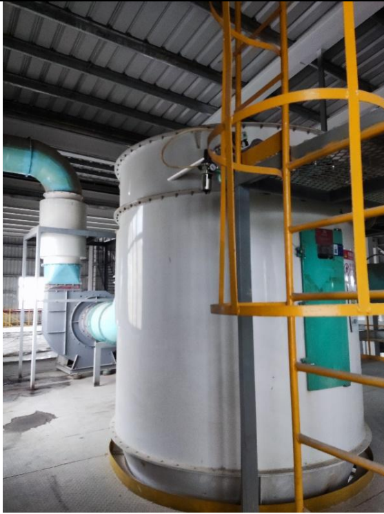
旋风+脉冲布袋除尘器（微粉粉碎）
