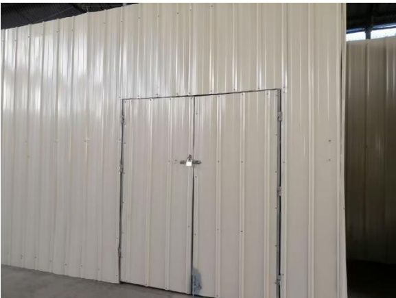
图 7 危险废物暂存间现状图 危险废物暂存间标识牌制作中。
