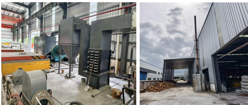
图4 旋风+水膜除尘及排气筒现状图
