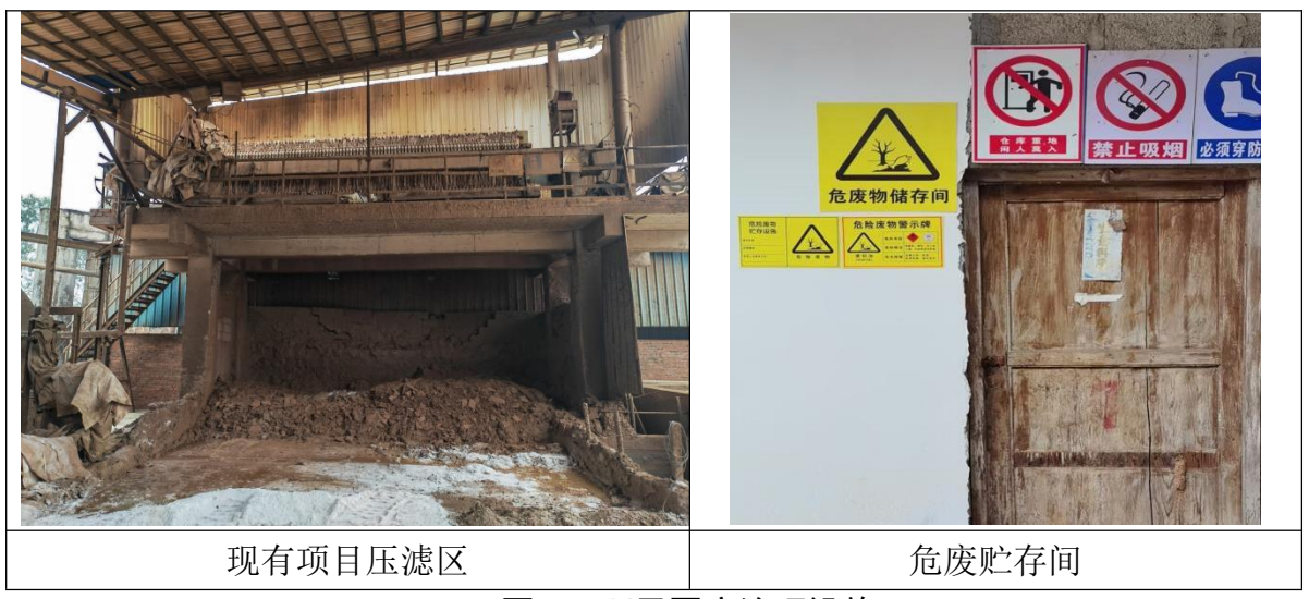
图5-4 项目固废治理设施
