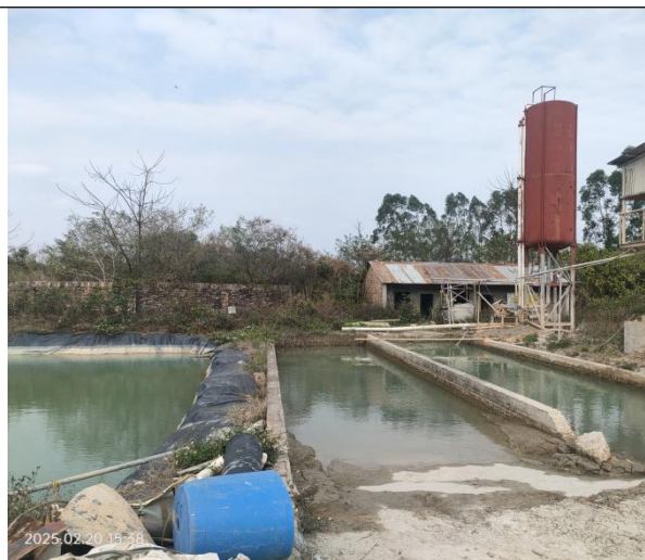
三级沉淀池及浓缩罐
