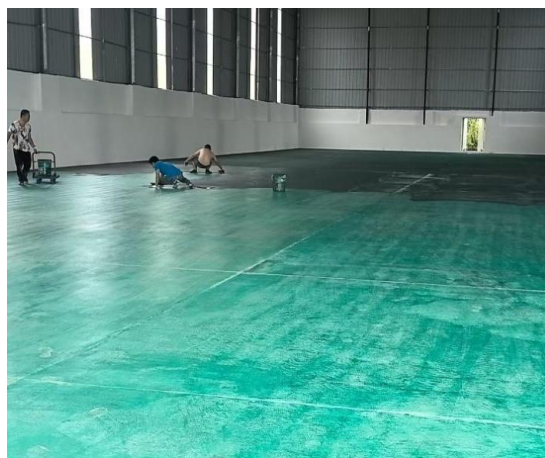
第二次底漆施工
