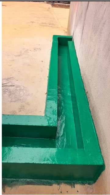
导流沟防渗施工
