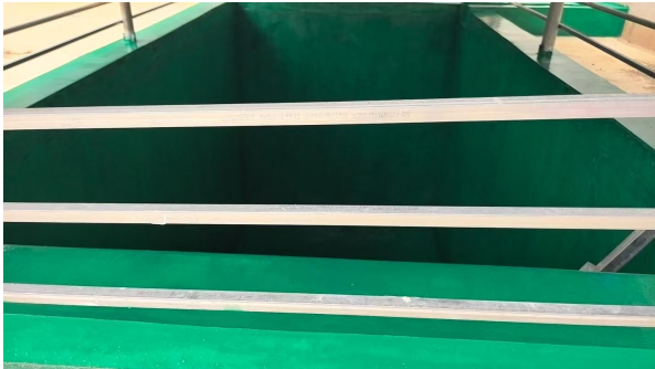
事故应急池防渗施工
