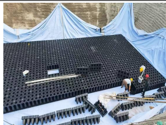
图 4-3 雨水调蓄池施工 1
