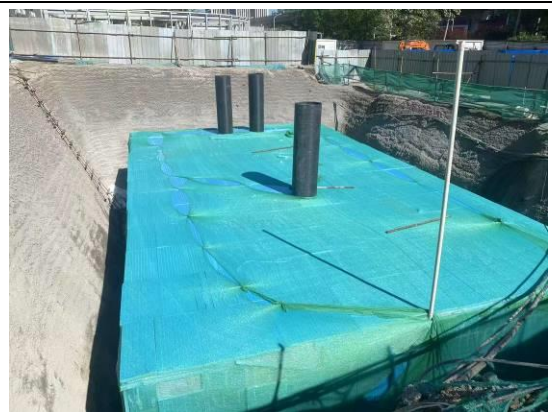
图 4-4 雨水调蓄池施工 2
