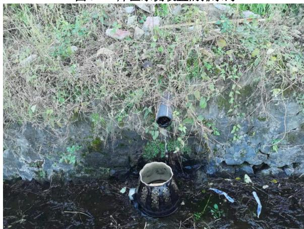
图 3-5 现有水平排渗管出水情况
