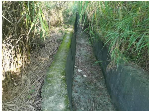
图 3-4 库区东侧设置的排水沟
