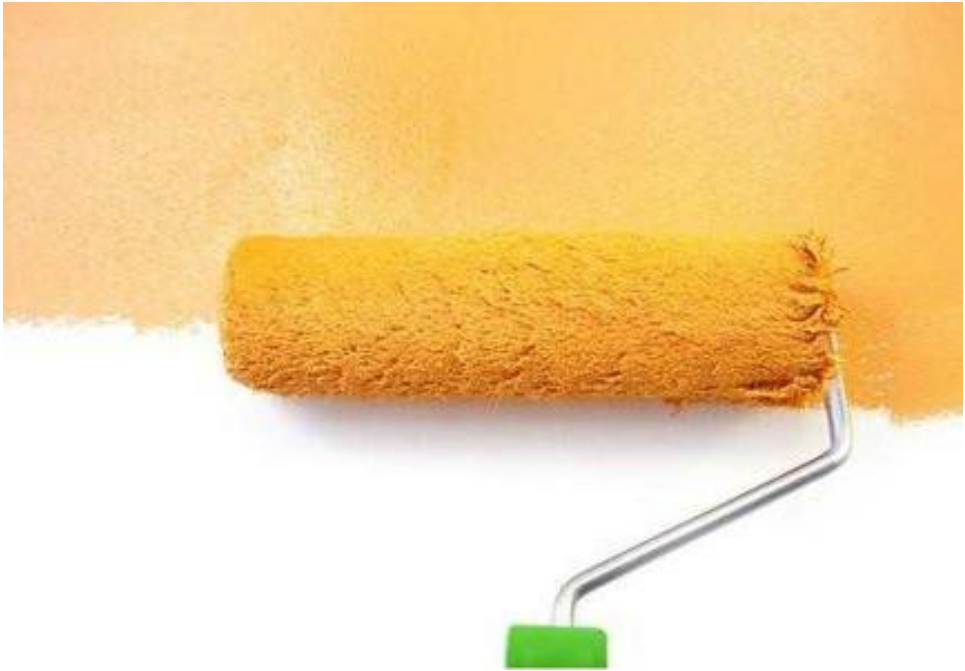
第三遍涂装施工以增加涂层厚度为核心目标，通过精细的辊涂工艺，确保漆膜均匀致密，为结构提供最终、可靠的防腐屏障。
