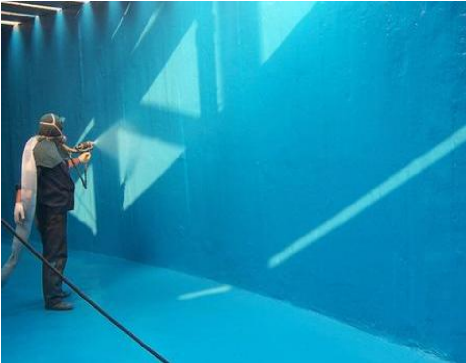
图为施工人员使用专业喷枪进行特种防腐涂料的喷涂作业，确保涂层均匀覆盖，形成有效的防腐屏障。
