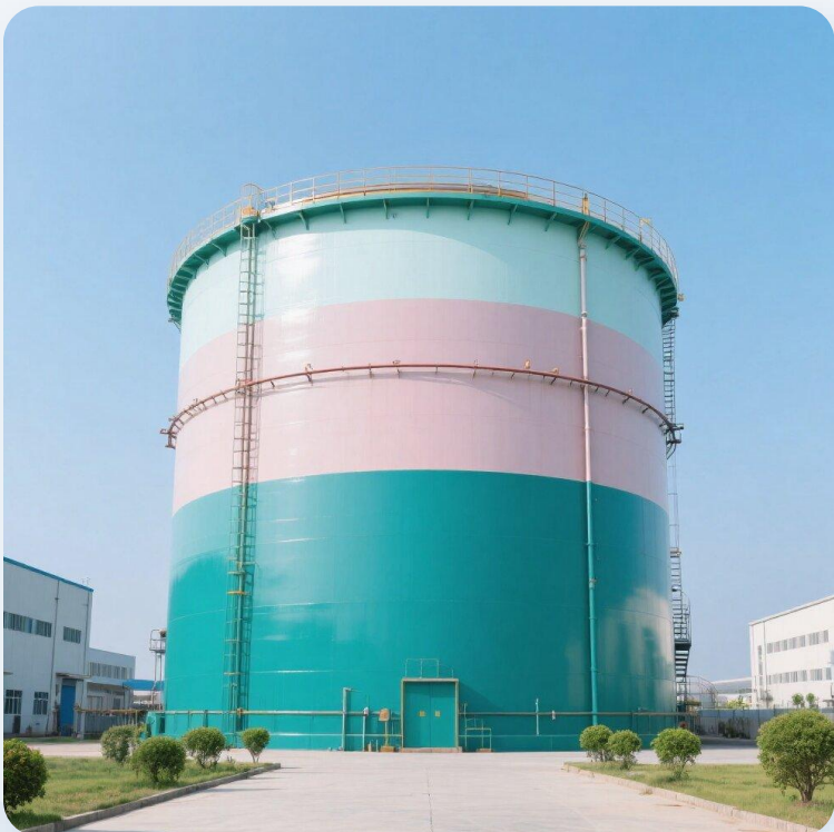
大型化工储罐防护应用实景 涂层附着力强，为设备提供长效物理屏障
