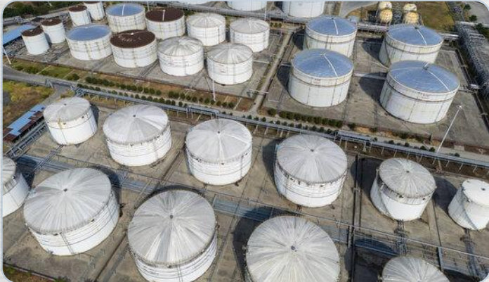
大型仓储储罐防护
